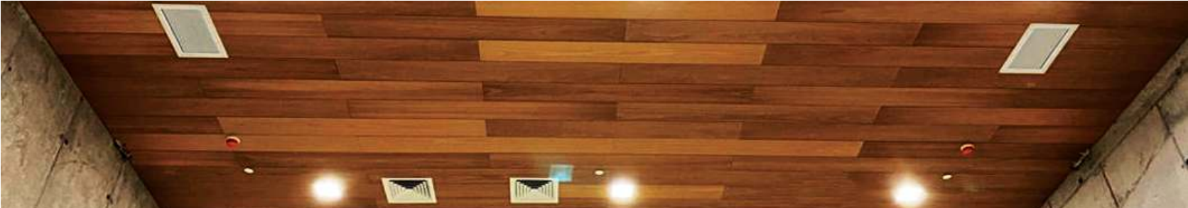
RANURADO TIPO 3 Ranuras de 480 x 8 mm Paso : 60 mm
